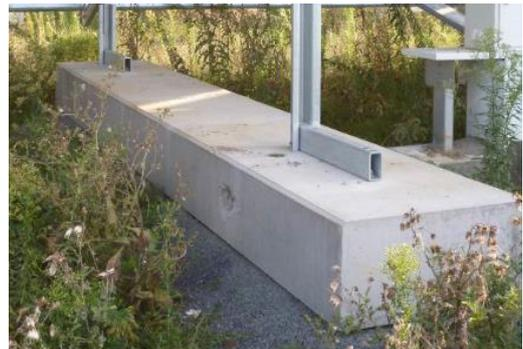
Figure 22 : Types de fondation - semelle béton
