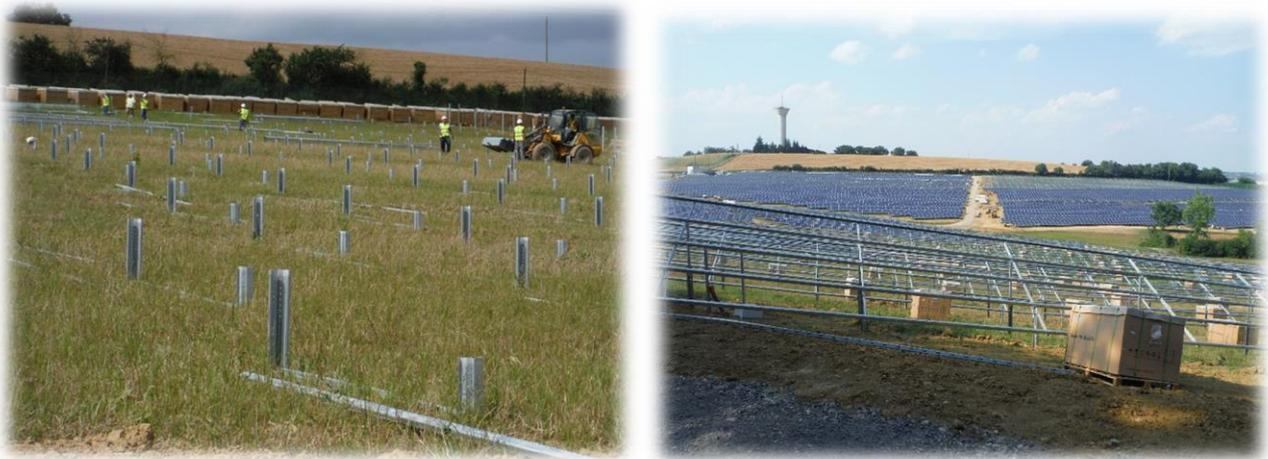
**Figure 31 : Exemple de chantier de construction – Pose des structures**
